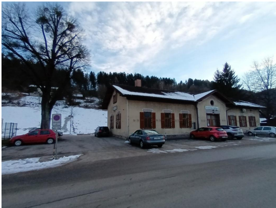
Slika 11: Stanje infrastrukture koroške železniške proge je za sodobne razmere neustrezno.
